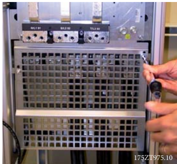
Kuva 3.52: EMC-standardin mukaisen suojuksen asentaminen.
