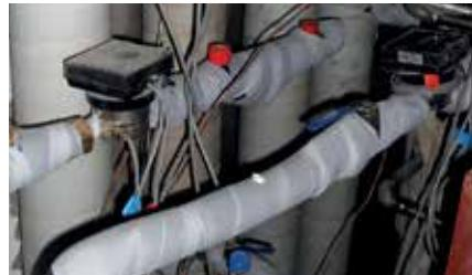
该建筑一梯四户，每户一套丹佛斯 ASV 压差平衡阀与热量表安装在管道井内。
