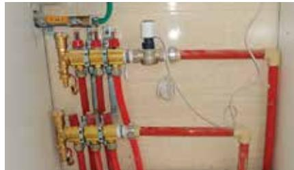
配有 RA-G 阀与 TWA-A 驱动器的丹佛斯分集水器。这种组合安装在面积较小的公寓内，通过主起居室内的 CWD 温控器进行集中温度控制。较大的公寓内安装有分室的房间温度控制装置。
