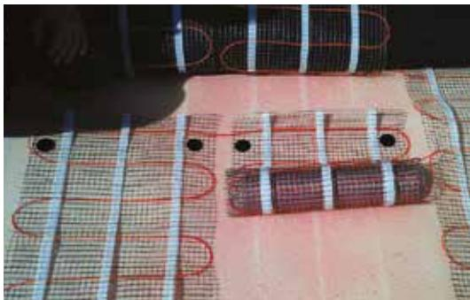
3. Fastgjør varmematten midt på banen ved hjelp av de spesielle karbonspikrene. Rull og strekk matten ut mot sidelinen.
