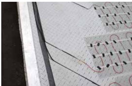
6. Kutt en rille i støtabsorberingen, men ikke i drenøringsmatten. Tilpass kaldendene, og før dem til nærmeste kabelbrønn.
