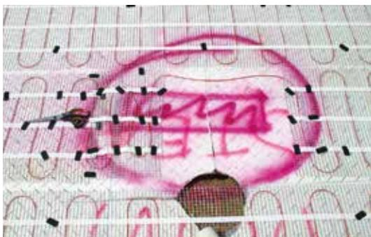
5. Husk å merke målposter, hjørneflagg osv. for å sikre at varmematte/kabler ikke skades når det lages hull til stolpene.
