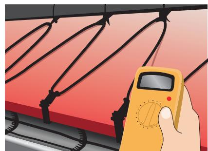
3. Проверьте сопротивление изоляции, а также электрическое сопротивление кабелей постоянной мощности. Установите кабель(-и) на крыше, в желобах и водосточных трубах.
