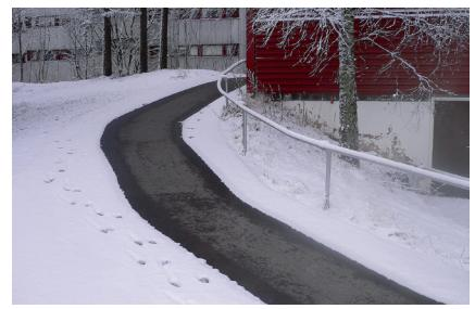
Необхідно контролювати температуру нагрівального елементу та не встановлювати його зовні при температурі навколошнього середовища вище 10 °C.
