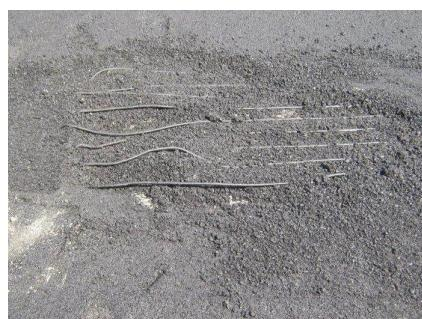
Для укладання другого шару асфальту слід використовувати барабан/каток при обмеженні максимального навантаження величиною 500 кг.
