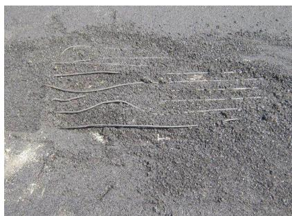
Для укладки второго слоя асфальта необходимо использовать барабан/каток максимальной нагрузкой 500 кг.
