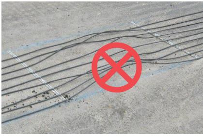
Нагревательные элементы не должны касаться друг друга или пересекаться между собой или с другими нагревательными элементами, и должны быть равномерно распределены по всей площади.
