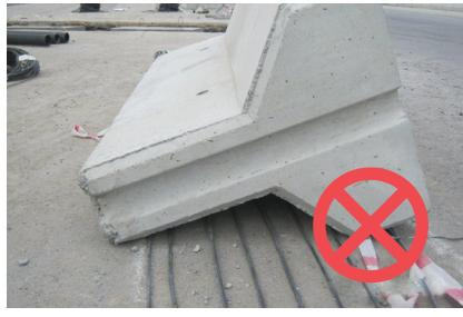
Необходимо обеспечить защиту нагревательных элементов и особенно соединительных муфт от давления и натяжения.
