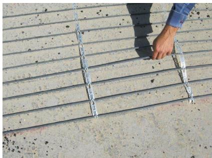
Обеспечьте защиту нагревательных кабелей от избыточного использования граблей, лопат, вибраторов или катков.
