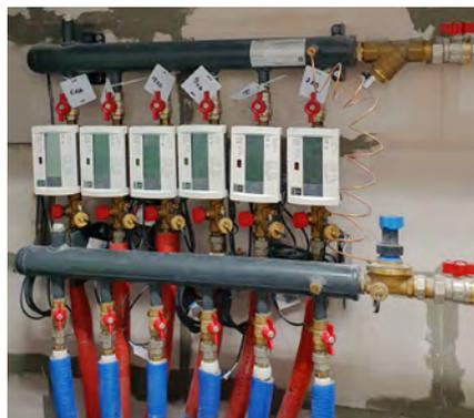
позволяют установить необходимые расходы теплоносителя по потребителям с обеспечением точнейшей балансировки.
