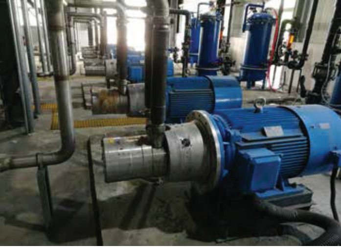
Chuan Ning Biologicals ZLD arıtma tesislerinde farklı hatlarda çalışan Danfoss APP pompaları
