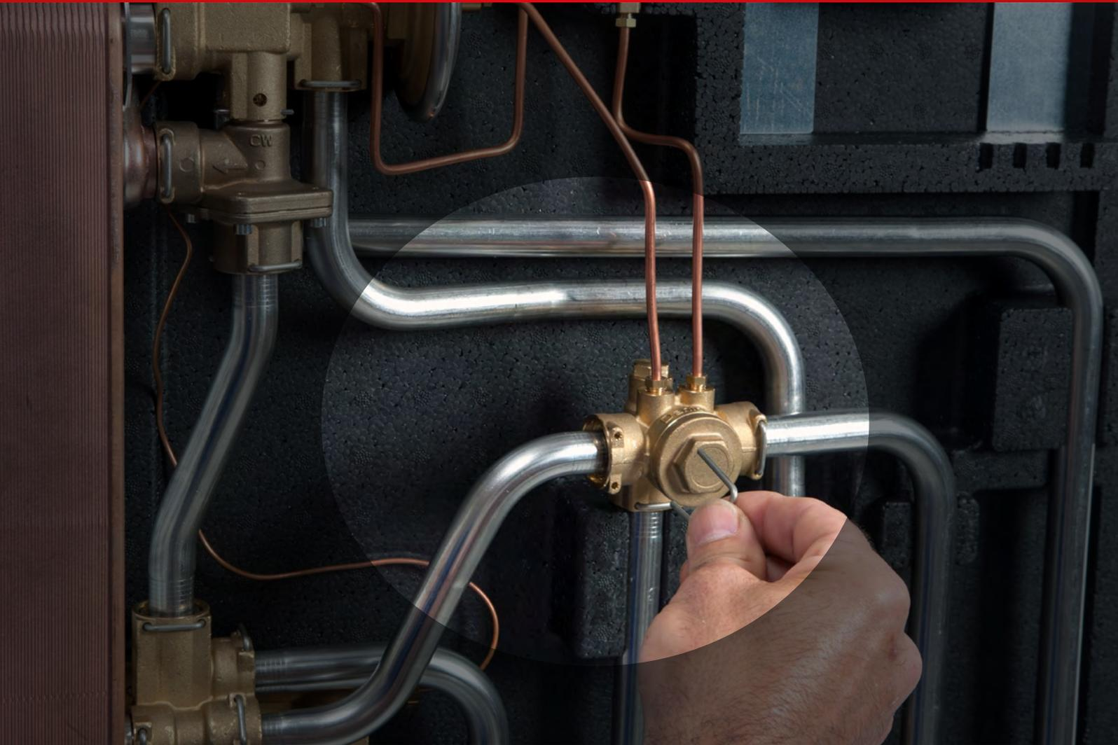
Bei traditionellen Wohnungsstationen, deren interne Rohre mit einfachen flachdichtenden Verschraubungen verbunden sind, kommt es regelmäßig vor, dass sich Verschraubungen während des Transportes lösen und dadurch undicht werden.
