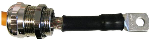
8. Führen Sie das Kabel durch die entsprechende Öffnung in der Verteilerbox und verbinden Sie den Kabelschuh mit dem Anschlusspunkt. Verwenden Sie eine Federscheibe zwischen Kabelschuh und Anschlussschraube oder -mutter. Die nachfolgende Abbildung zeigt ein Anschlussbeispiel. Ziehen Sie die Verbindung noch nicht fest, um den korrekten Sitz der Kabelverschraubung sicherzustellen.
