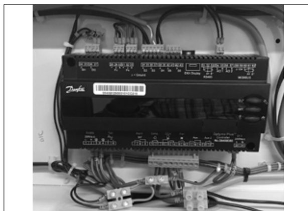
Rysunek 5: Okablowanie tymczasowe
