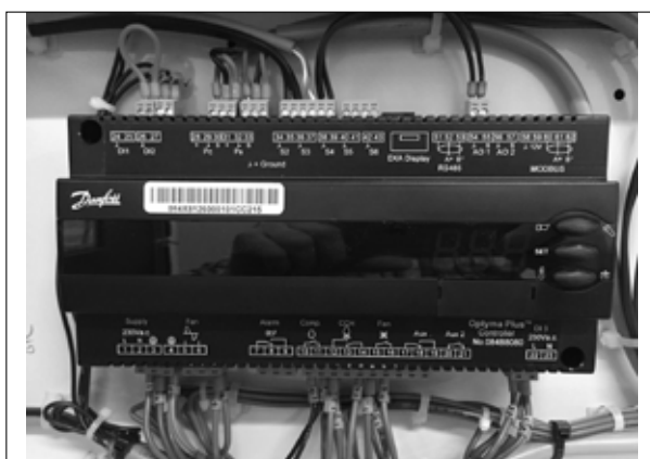
Illustration 4 : Câblage normal
