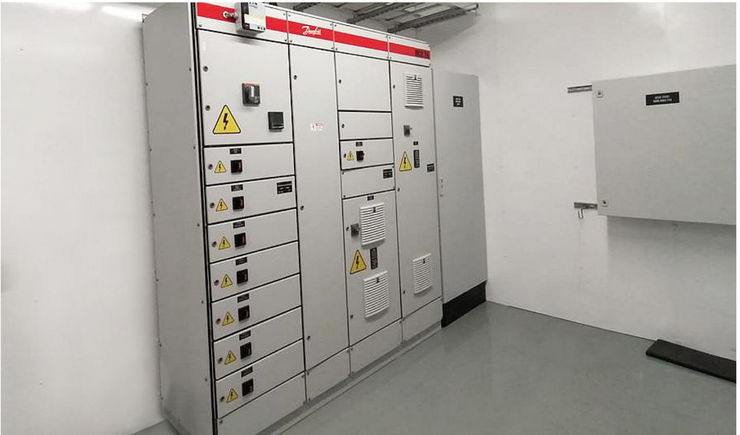
Los nuevos CCM extraíbles para **OMYA**, se instalaron en los gabinetes modulares hechos por CUBIC, socio tecnológico de Danfoss que comulga con la visión del diseño estético, funcional y ergonómico para el manejo independiente de cada uno de los drives. Esto permite tener una solución nueva en la línea de productos Danfoss con dos grandes ventajas: absoluta seguridad del personal de operación y mantenimiento, sin interrupciones al intervenir una sección del sistema.
