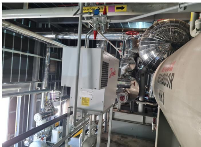
La alta presión de descarga de los compresores y la ineficiencia de los sistemas de purga tradicionales reducen la producción en las plantas, ya que en muchas ocasiones los compresores se apagan por la alta presión de descarga. Asimismo, al hacer la purga manualmente y sin control de la demanda, el amoníaco es liberado en exceso en el medio ambiente, lo que implica riesgos de accidentes y costos de reemplazo del refrigerante que se desechó innecesariamente.
