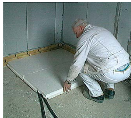
Montaż izolacji
