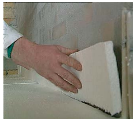
Montaż izolacji pionowej
