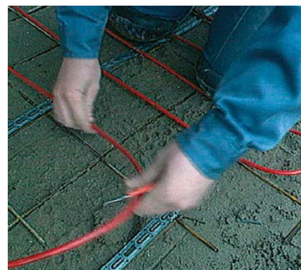
Montaż kabla grzejnego
