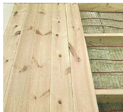
Montaż ogrzewania podłogi drewnianej na legarach
