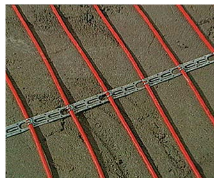
Kabel grzejny przymocowany do taśmy DEVIfast™
