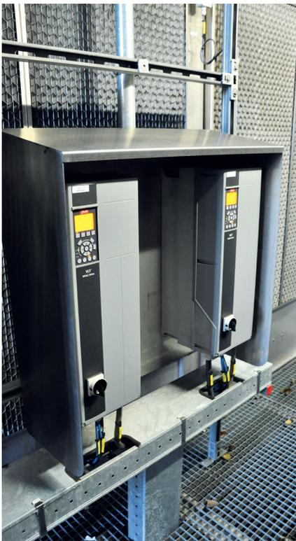
用于冷却塔调节的室外装置包括两台 VLT® HVAC Drive FC 102 变频器, 该变频器采用 IP55 机箱, 内置断路器。
