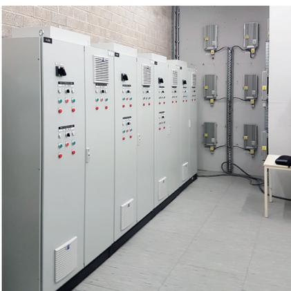
L'un des deux locaux techniques avec des résistances de freinage sur le mur du fond.
