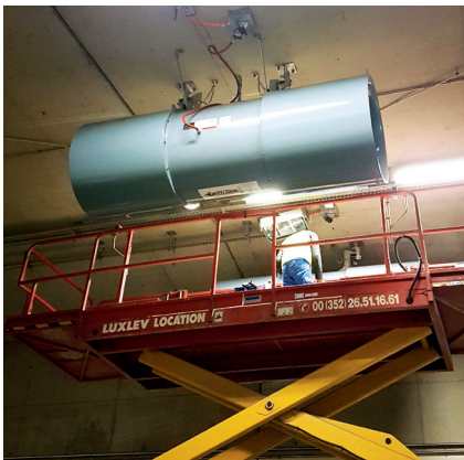
Intervention sur une unité de ventilation.
