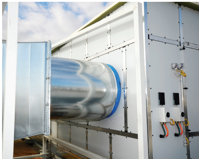
风机出口和管道系统之间的连接
