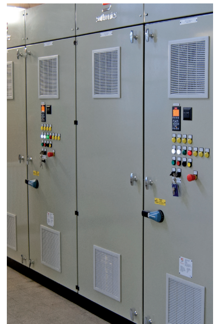
Panele sterowania silnikami w Affinity Water
