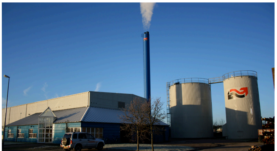
SRO-anlægget giver Auning Varmeværk overblik over alle driftsdata for begge varmegærker.
