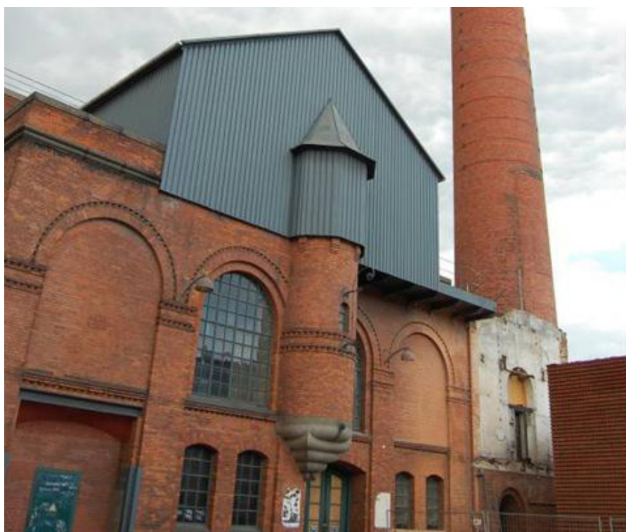
Une ancienne centrale électrique située près de la place Kongens Nytorv, au centre de Copenhague, a eu droit à une seconde vie. Celle-ci constitue désormais le point de départ de la première installation de refroidissement urbain à grande échelle du Danemark. Ce nouveau système permet de refroidir de grands bâtiments commerciaux tels que des banques, des hôtels, des immeubles de bureaux et de nombreuses autres entreprises, le tout de manière économique et écologique.
