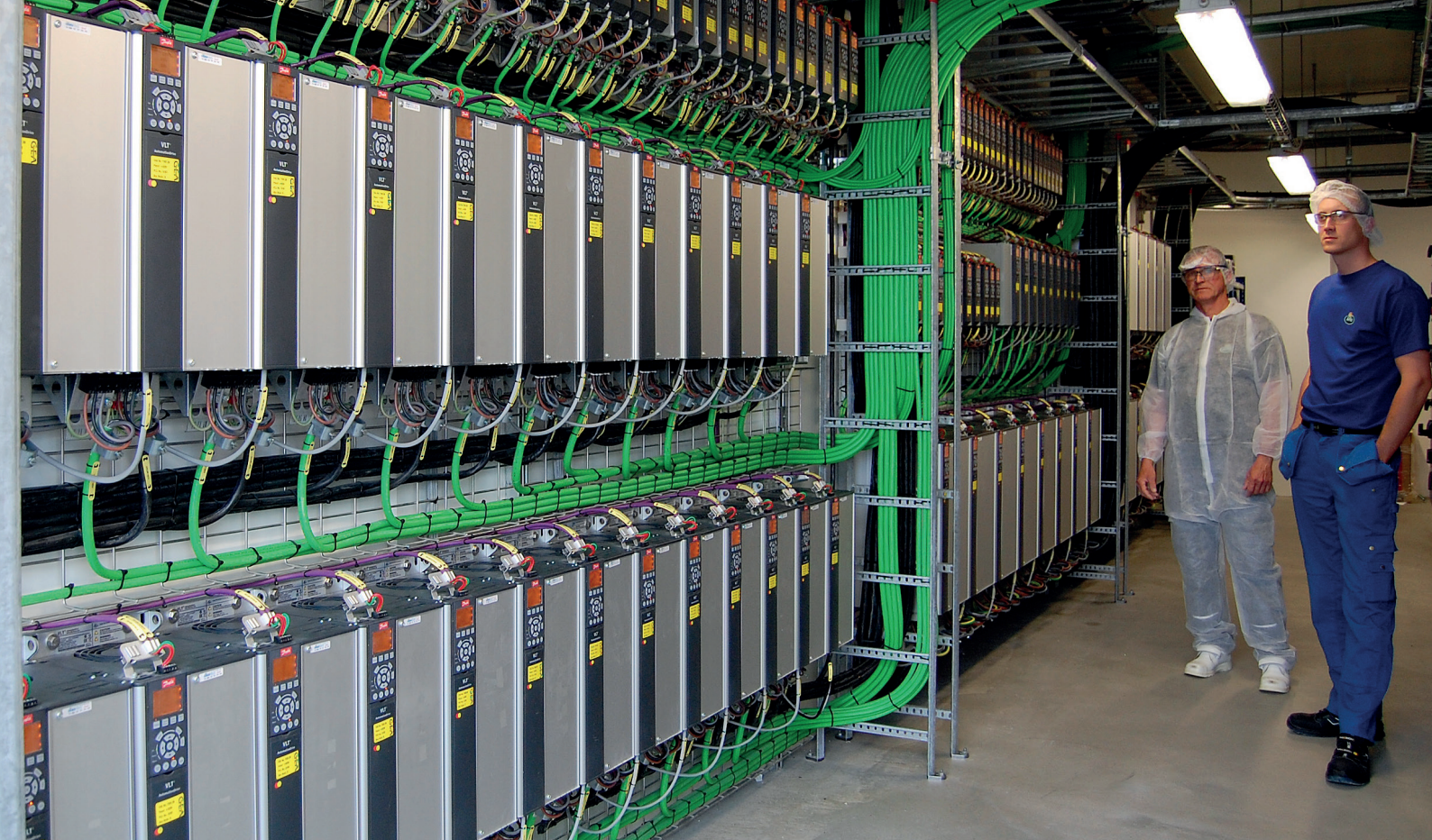
De 1.400 VLT® frekvensomformere er monteret i en serie af velventilerede kontrolrum uden et behov for kabinetter. Fra venstre driftschefen for Arla Foods Ingredients Group i Videbæk, Knud Rahbek, og vedligeholdelseschef, Simon Arentoft
