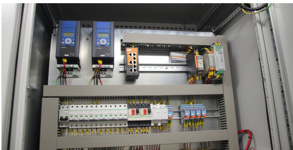
Kablingsområde som er lett å komme til. Også ventilasjonsviftene til containeren drives av VACON® frekvensomformere.
