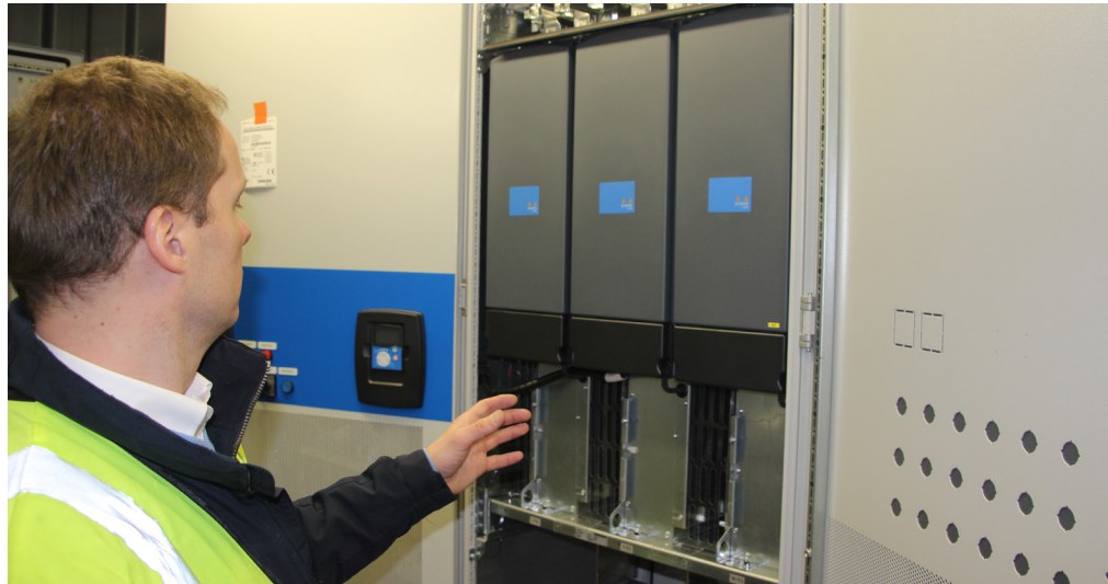
Frekvensomformer.no公司的Sverre Knapstad正在展示机箱中安装的VACON® NXP模块
