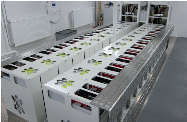
2 x 68 kWh Li-Ion batterijen met batterijbeheersysteem.
