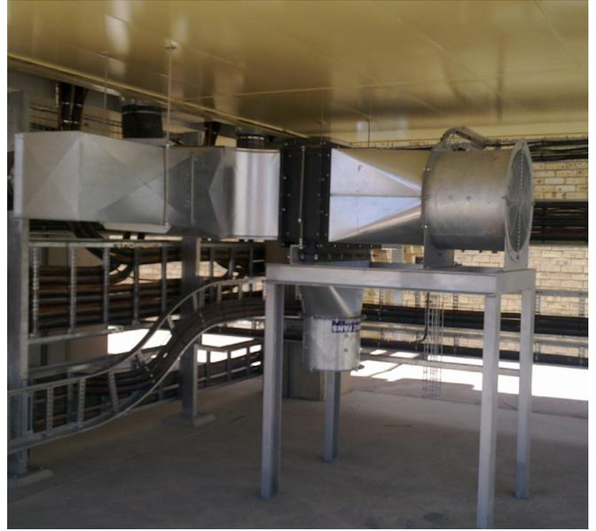
无维护旋转过滤系统会去除空气中的灰尘，避免进入变频器的散热通道。
