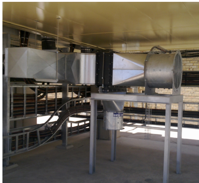
Filtr typu spin niewymagający konserwacji usuwa pył z powietrza zanim dostanie się ono do kanału radiatora przetwornicy częstotliwości.
