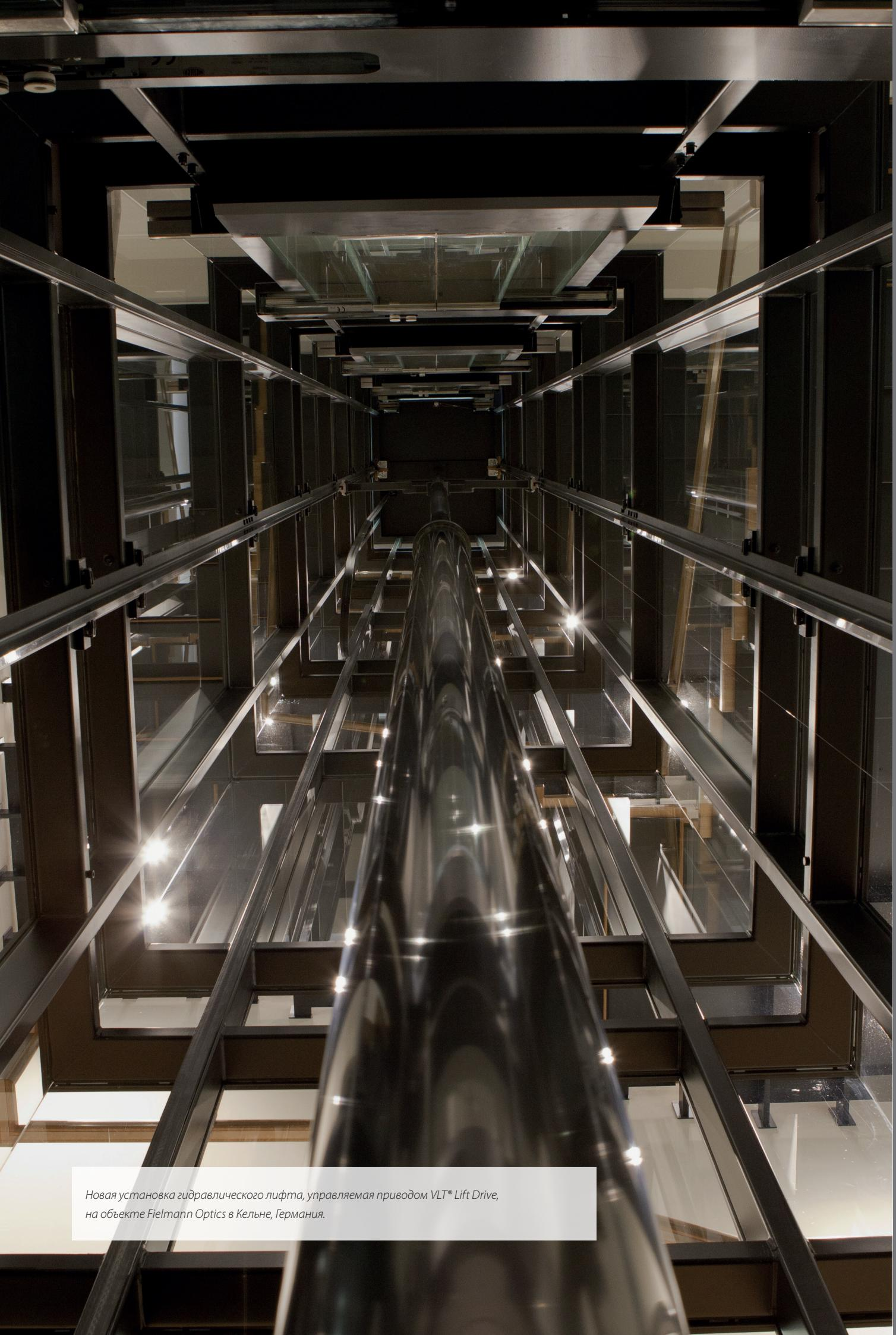
Новая установка гидравлического лифта, управляемая приводом VLT® Lift Drive,
