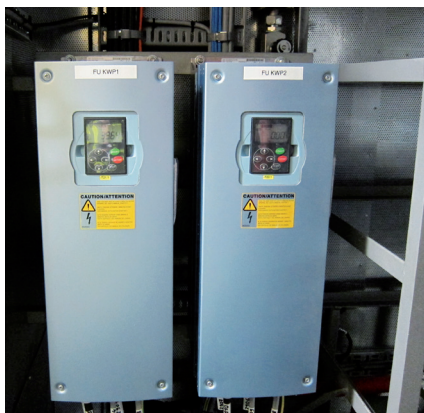
冷却水泵的变频器
