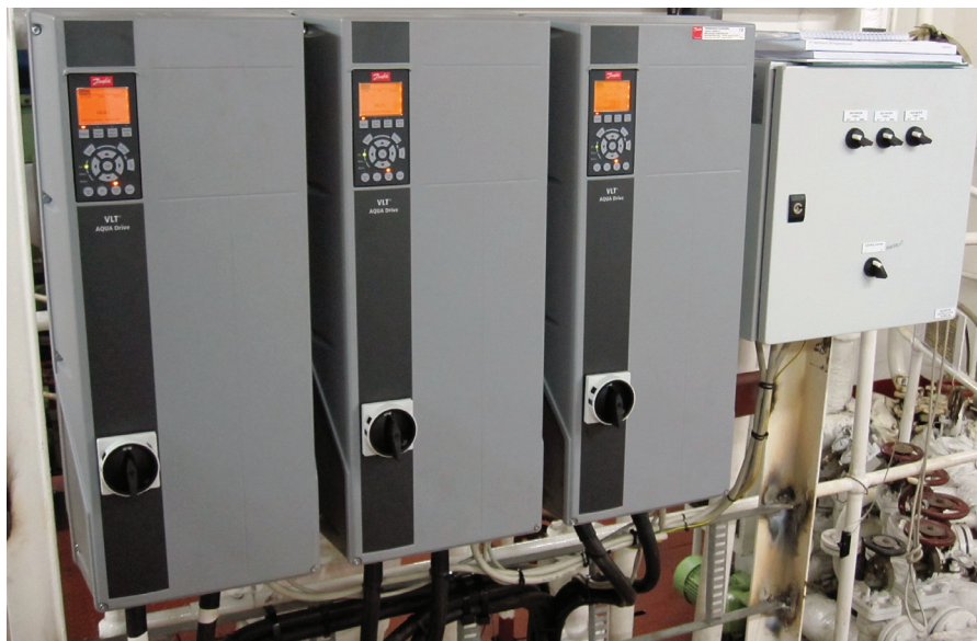
Frekvensomformerløsningen hos Dampskibsselskabet NORDEN A/S består af 3 VLT® AQUA Drive FC 202, 45 kW frekvensomformere med kaskadekontrol, en elektrisk switchboks til kontrol og to temperaturtransmittere.
