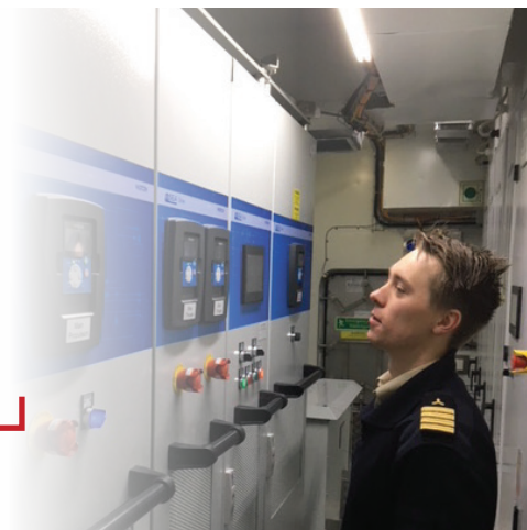
Die VACON® Frequenzumrichter bedienen den Hauptmotor und die Strahlruder
