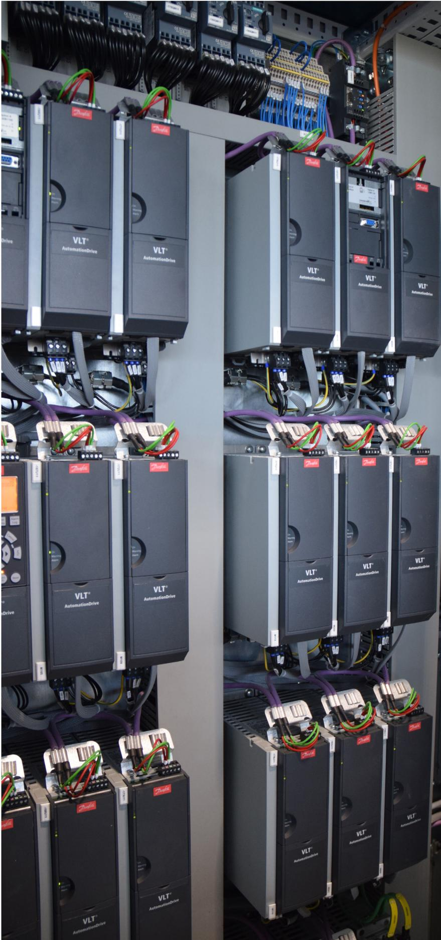
*Inverter Danfoss VLT® AutomationDrive FC 302 di taglie appropriate all'esigenza del tipo di trasportatore installati nell'armadio, progettati per il controllo a velocità variabile di tutti i motori sincroni a riluttanza, magneti permanenti e motori asincroni, pensati per aumentare la flessibilità e ottimizzare il controllo dei processi su qualsiasi macchina industriale o linea di produzione.*
