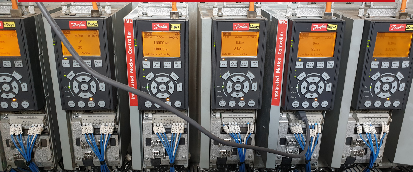
蓝色电缆显示来自编码器的通信 - 黄色电缆用于 Modbus TCP 通信
