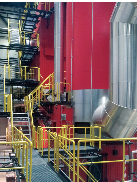
Vertikal biobrændselskedel og rensning af røggas
