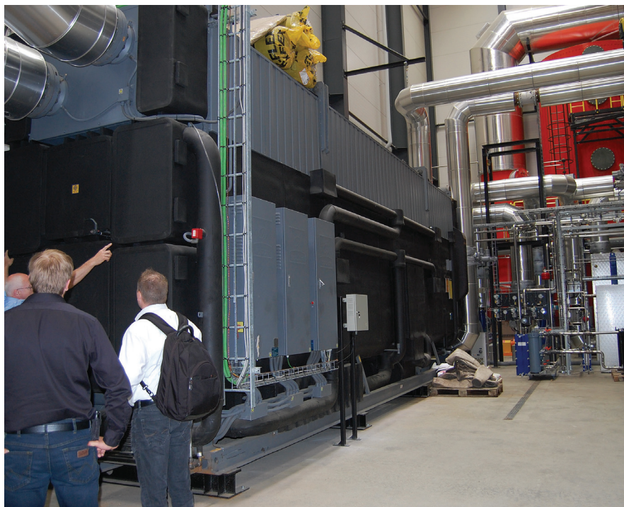
I forgrunden en absorber. I baggrunden skrubber.
