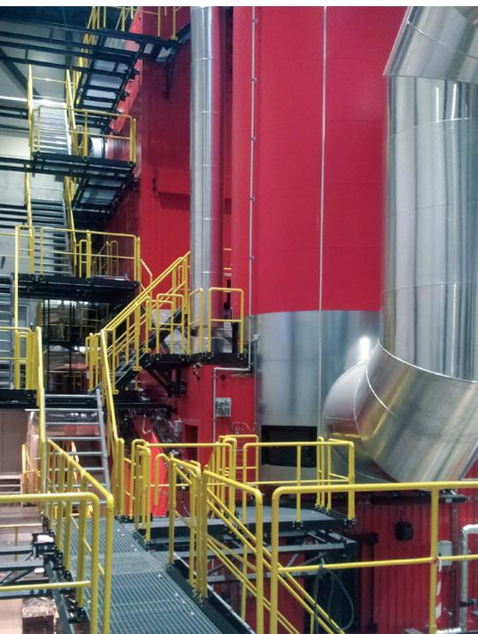
Chaudière verticale à biocarburants et épurateur des gaz de combustion par grenailage.
