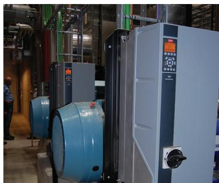
Moteurs SynRM IE4 équipés de variateurs de fréquence VLT® AutomationDrive FC302.
