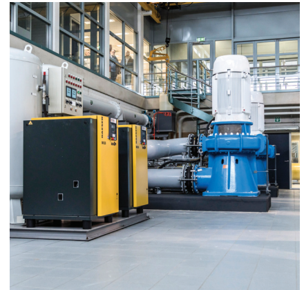
Om de grote hoeveelheid water door de hyperfiltratie te pompen, is veel vermogen en energie nodig. Frequentieomvormers zorgen er voor dat de pompen niet meer toeren maken dan noodzakelijk, waardoor veel energie wordt bespaard én het geluidsniveau wordt beperkt.
