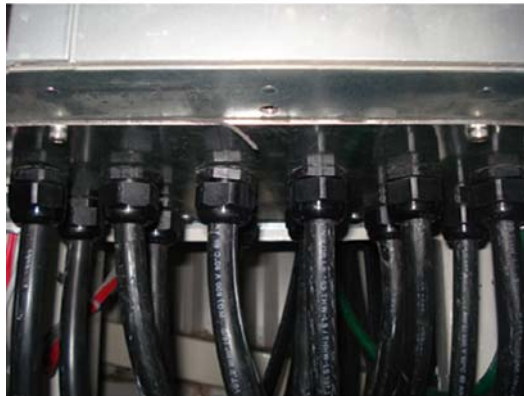
Abbildung 3.14: Beispiel für richtige Befestigung des Bodenblechs.
