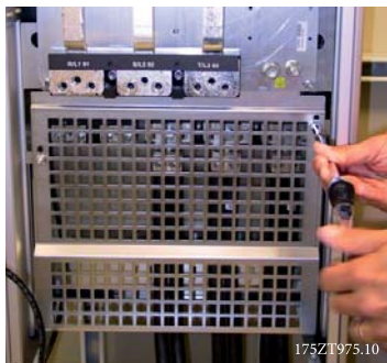
Kuva 3.50: EMC-standardin mukaisen suojuksen asentaminen.
