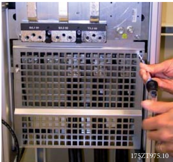
Kuva 3.52: EMC-standardin mukaisen suojuksen asentaminen.
