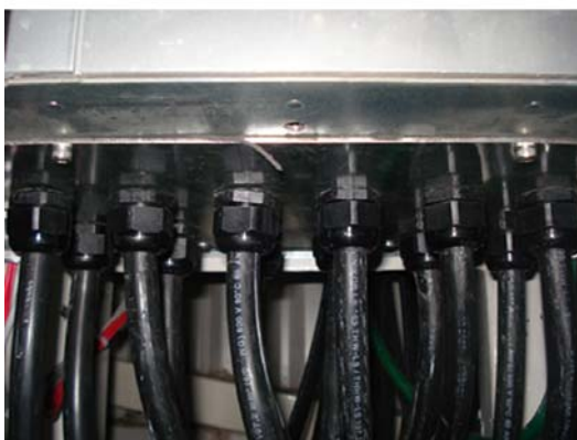
Ilustração 3.32: Exemplo de instalação correta da placa da bucha.
