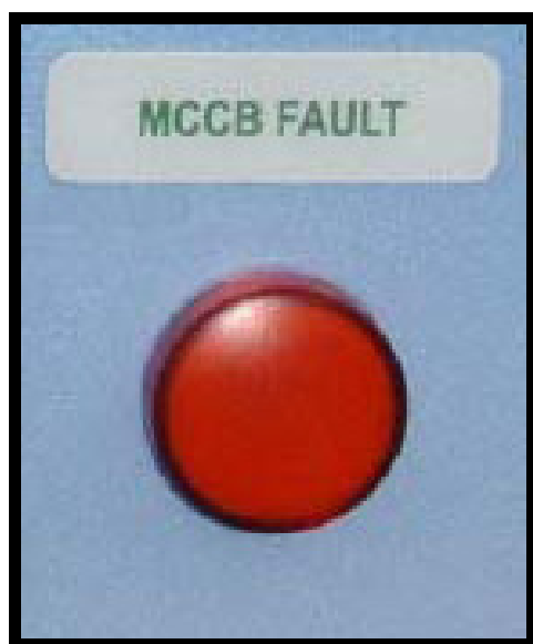
图 29. MCCB 故障指示灯
