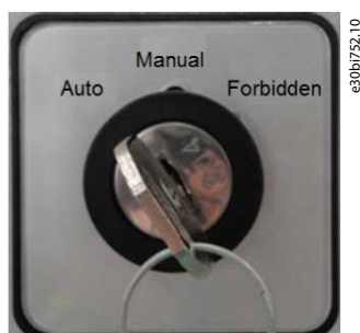
Ilustração 21: Seletor do Modo de Operação SF1
