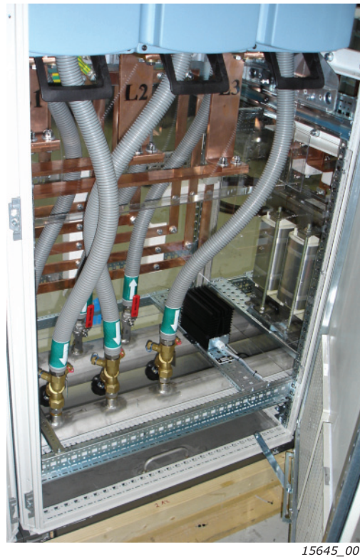
图 30. 供水软管的安装示例
