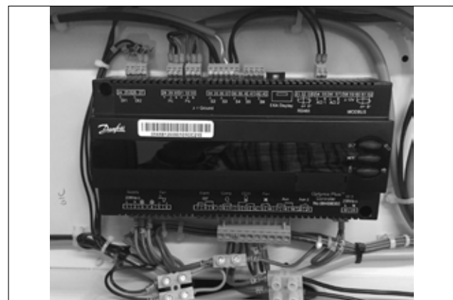
Bild 5: Tillfälliga anslutningar
