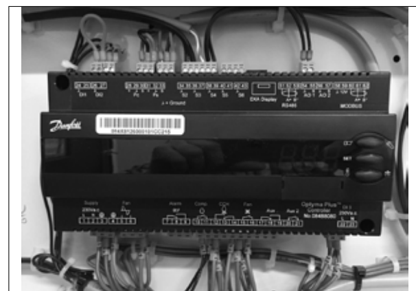
Εικόνα 4: Κανονική καλωδίωση
