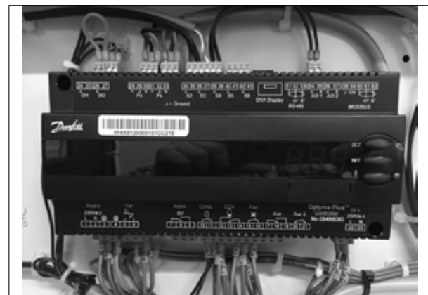
Bilde 4: Normal kabling
