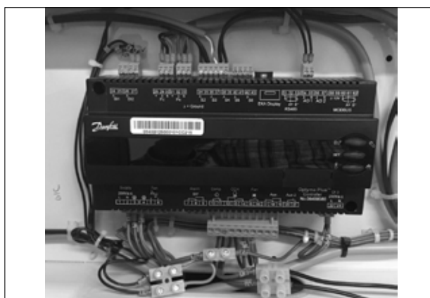
Obrázek 5: Dočasné zapojení
