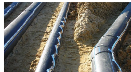
Frostsikring rørstrækning i Strzelce Opolskie, Polen
