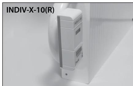
**ВНИМАНИЕ!** При монтаже счетчика-распределителя тепла INDIV-X-10(R) с дистанционным считыванием показаний зафиксировать корпус на платформе для крепления счетчика-распределителя, **не защелкивая его до конца**.
