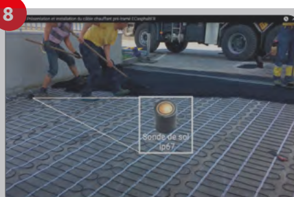
Présentation et installation du câble chauffant pré-tramé DEVlasphalt
