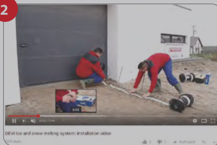
Installation des systèmes de déneigement et mise hors gel
