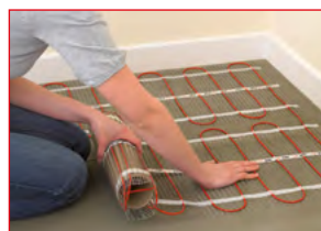
Recouvrir la surface selon le plan de pose.
