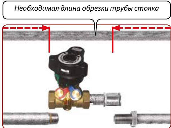
Следует отрезать участок длиной, как показано на рисунке (клапан, вкрученный в него патрубок, и одетый бочонок). Также необходимо предусмотреть небольшой зазор для резьбы на концах трубопроводов стояка, которые будут вкручены в клапан с одной стороны, а в бочонок — с другой.
