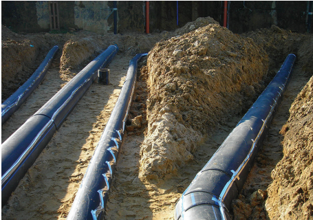
Conduite a Strzelce Opolskie, Polonia
