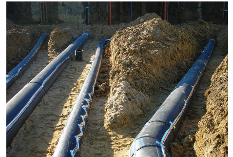
Pijpleiding in Strzelce Opolskie, Polen
