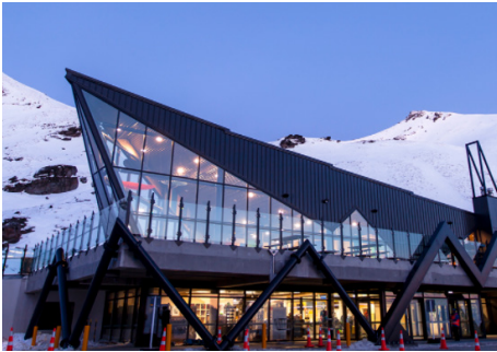
Pista de esqui Remarkables Queenstown, Nova Zelândia Um sistema de derretimento de neve e gelo foi instalado no pátio externo do edifício base, dividido em 22 zonas. A dimensão do projeto é de 2500 m².
