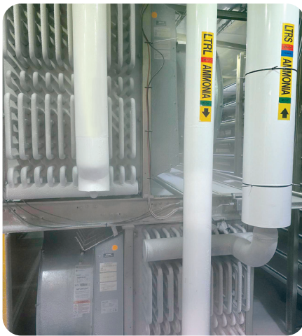
↑ Vista lateral del serpentín del congelador. Cortesía de Perry's Ice Cream.
